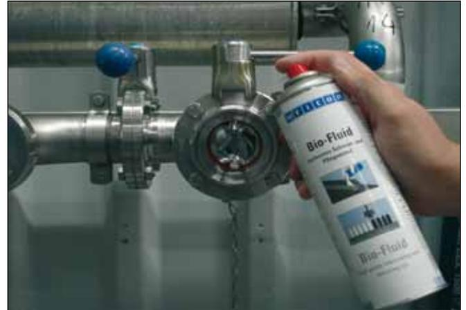
Das wasserhelle und lösemittelfreie Produkt ist geruchs- und geschmacksneutral, kriechfähig sowie wasserabweisend. Es mindert Reibung und Verschleiß, unterdrückt Quietschgeräusche, schützt vor Korrosion und löst Schmutz und Rost.
